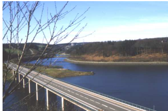
Abb. 90: 8 Jahre später führte die neue Brücke über die Wuppertalsperre
