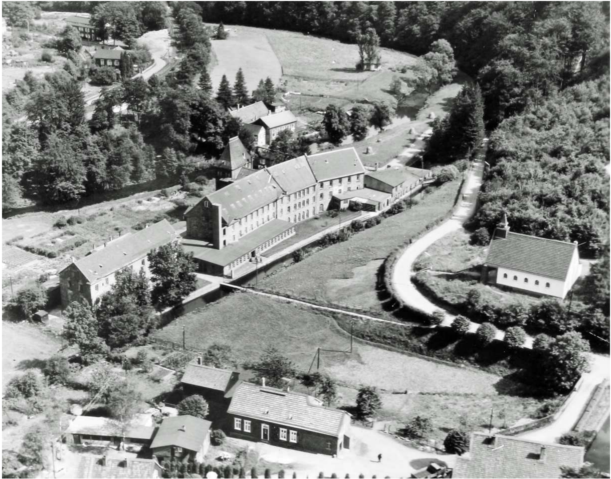
Abb. 37. Die Aufnahme vom Ende der 1950er Jahre zeigt die Krebssoeger Fabrik noch einmal in ihrer alten Bruchsteinpracht. Deutlich erkennt man den Karschgraben, durch den das Wasser zur Turbine am östlichen Ende der Fabrik fließt
