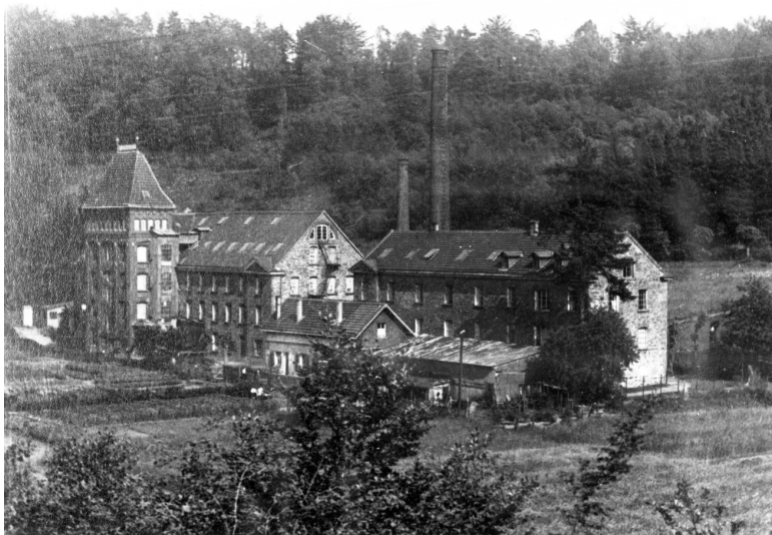
Abb. 26.: Die Schornsteine sind nur noch Makulatur. Hauptenergie ist elektrischer Strom
